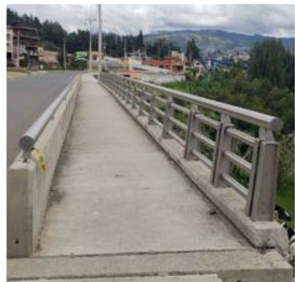
FIG. 20. Barandas ubicadas a los costados de la luz de los puentes.
