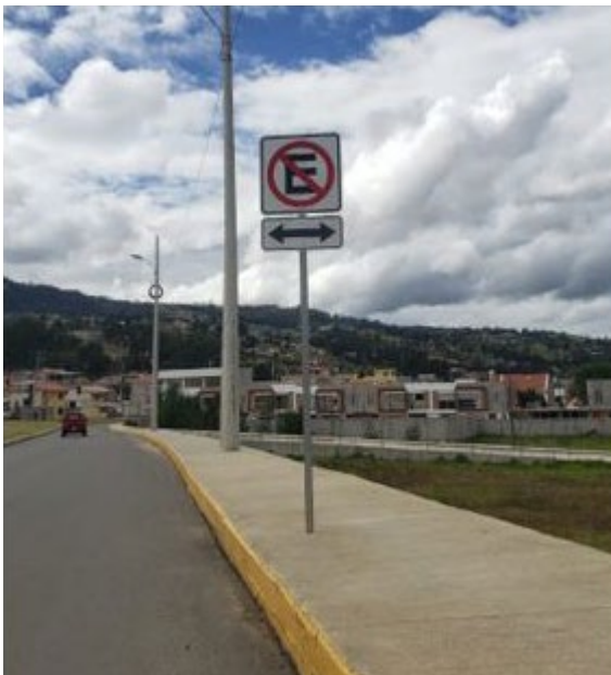
FIG. 18. Señal de No estacionar en el puente.norte-sur
