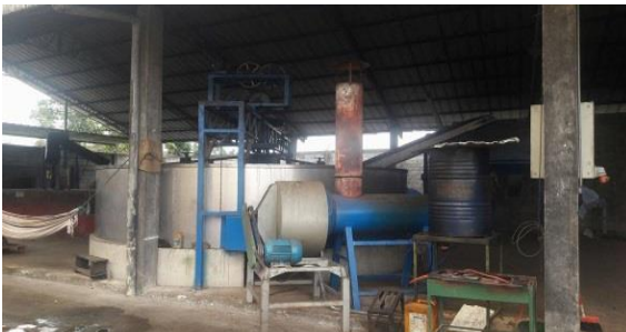
Figura 2. Instalaciones de la corporación
