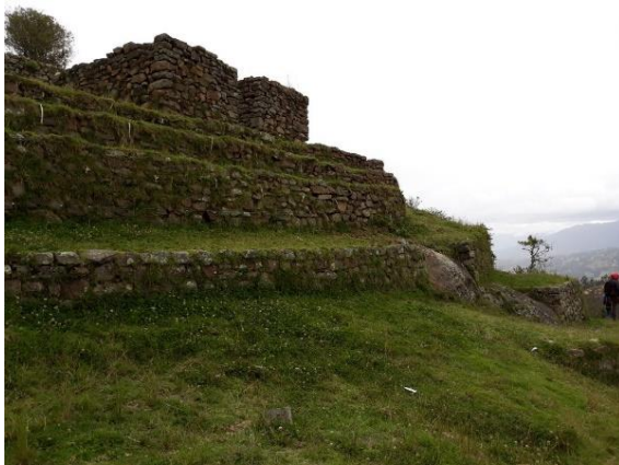
Fig. 4. Fragmento de complejo anterior a intervención Fuente: Propia
