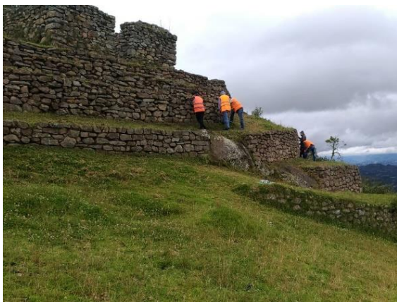
Fig. 5. Fragmento de complejo anterior a intervención Fuente: Propia
